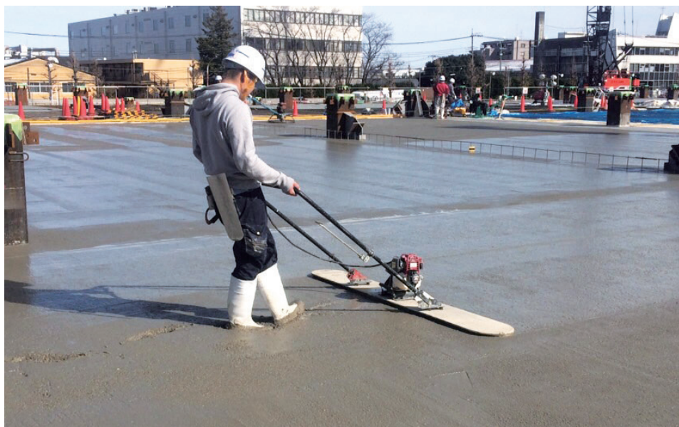
タンピングと締固めで密実なコンクリート下地を実現
