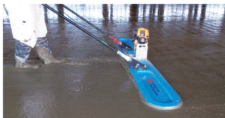
写真2 再振動型締固機（サーファー）
